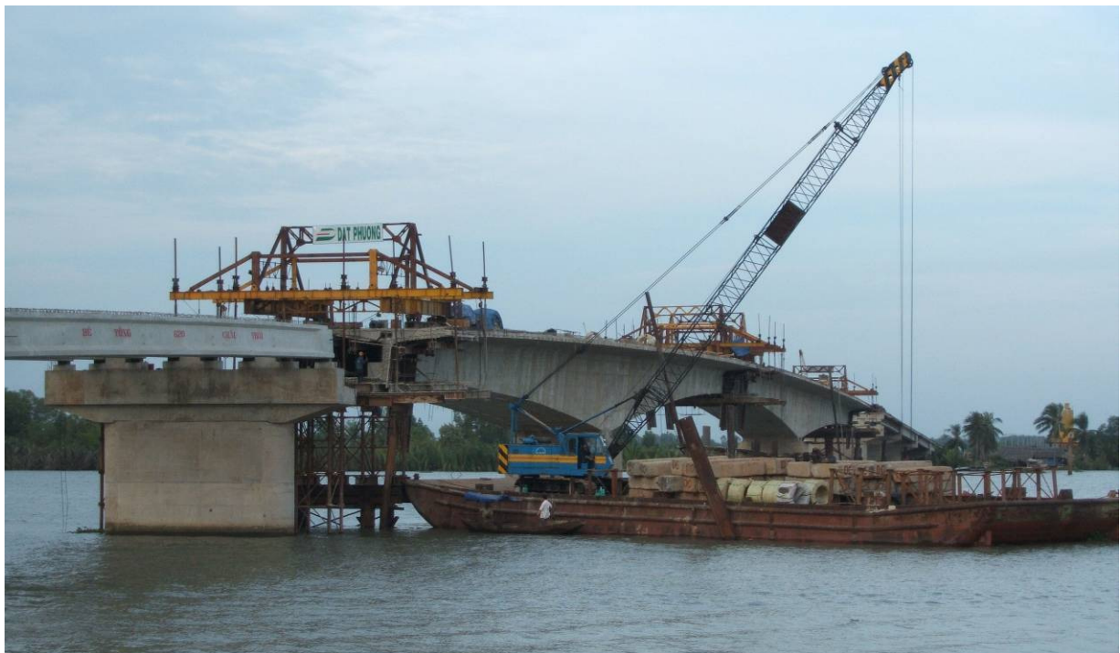
Cầu Đại Phước vượt Sông Sâu vào Dự án Khu đô thị du lịch sinh thái Đại Phước do DIC đầu tư tại H. Nhơn Trạch, ĐN. Với chiều dài 530 m, có tổng mức đầu tư trên 200 tỷ đồng. Sẽ hợp long vào 15.01.2009 và đưa vào sử dụng vào dịp 30.4.2009.
